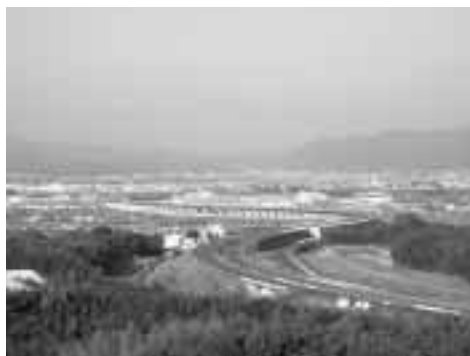
第二京阪道路（欽明台地区から）
