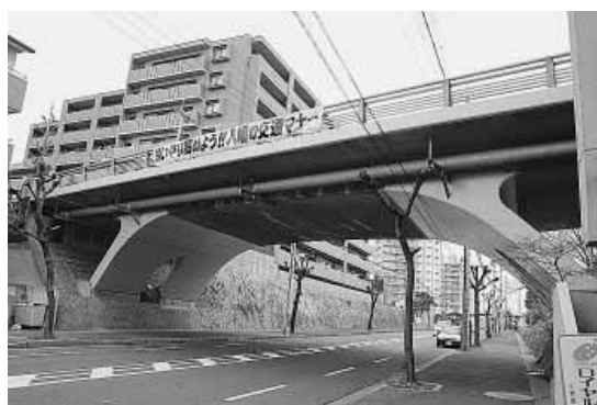
橋の長寿命化修繕計画に基づき補修された長沢陸橋
