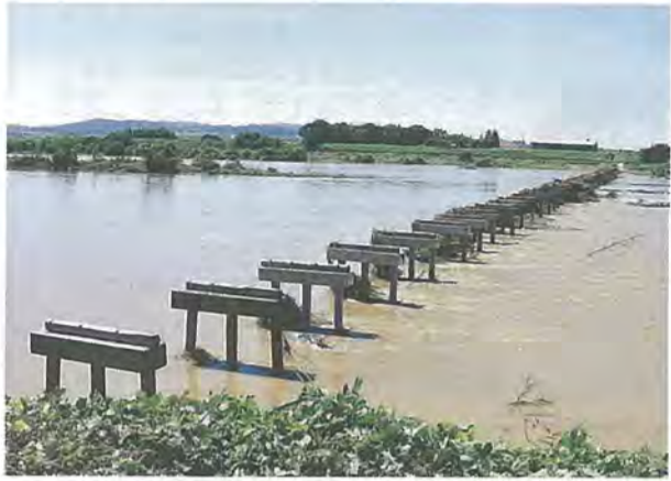
橋板が流されて橋脚だけになった流れ橋
