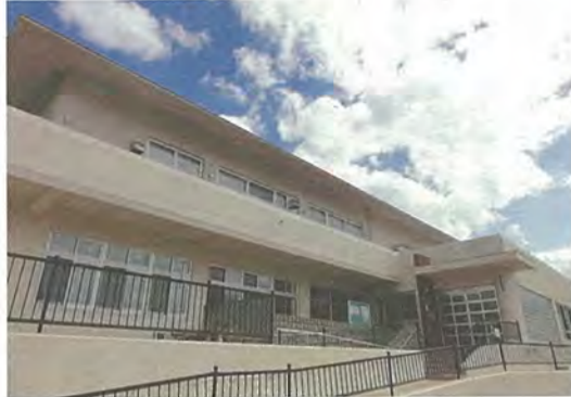
工事が完了した橋本公民館
