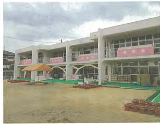
工事が完了した園舎
