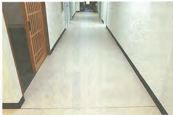
滑りにくい材質に変更された廊下
