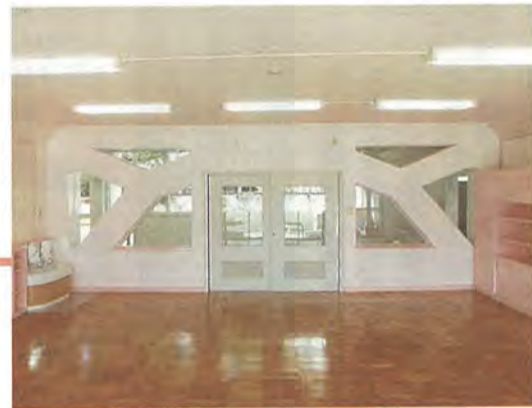
鉄骨ブレースで補強された保育室
