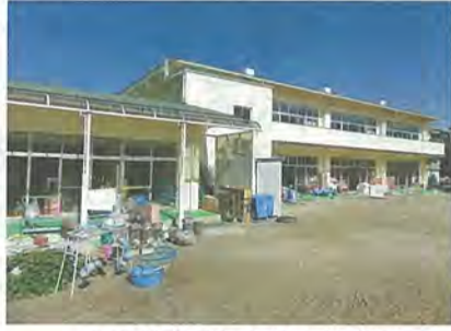
工事が完了した橋本幼稚園
