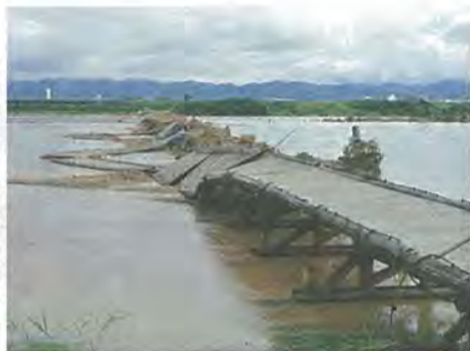
木津川の増水で橋脚が流れた「流れ橋」(上津屋)
