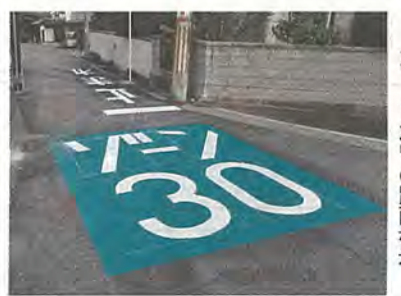
「ゾーン30」の路面標示
