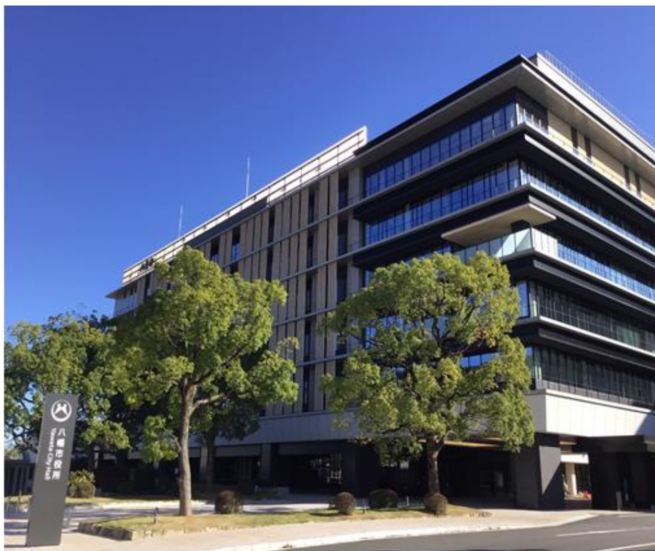
八幡市役所 新庁舎
