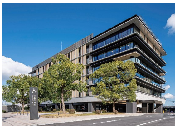
八幡市役所新庁舎
