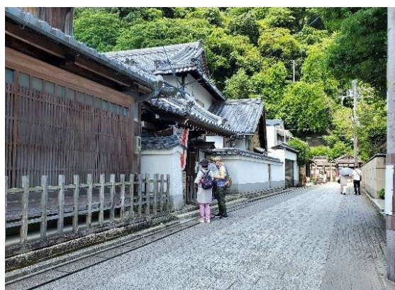
街道の路面整備
