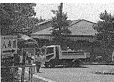
改修工事をすすめる八寿園
