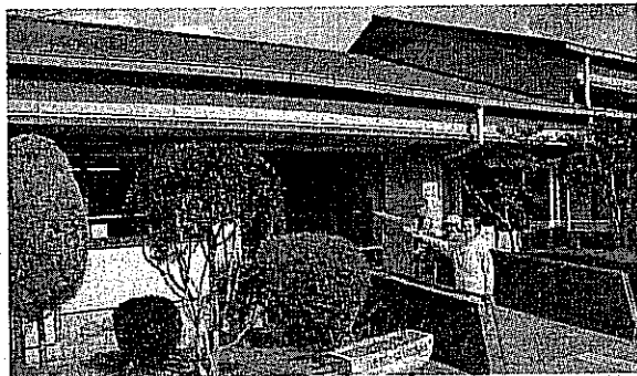
介護予防事業の拠点とするため整備する老人憩いの家・八寿園
