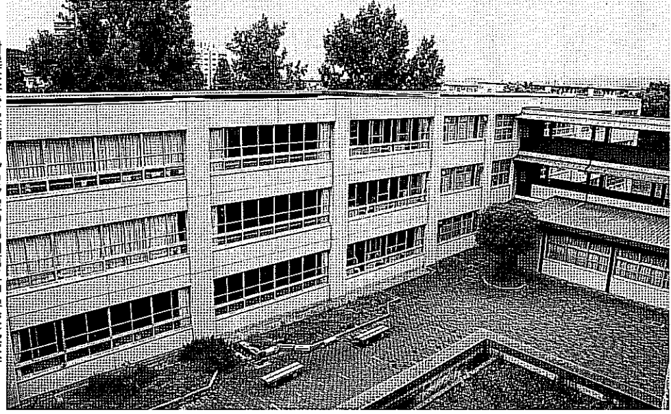
耐震診断が実施される予定の男山第2中学校北校舎
