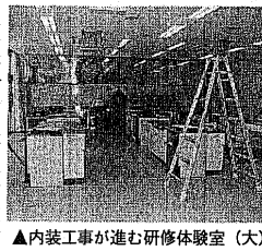
▲内装工事が進む研修体験室(大)
