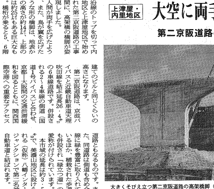
大きくそびえ立つ第二京阪道路の高架橋脚(内里荒場地域の東部)
