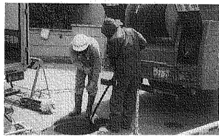
つまった下水道管を洗浄する作業員
