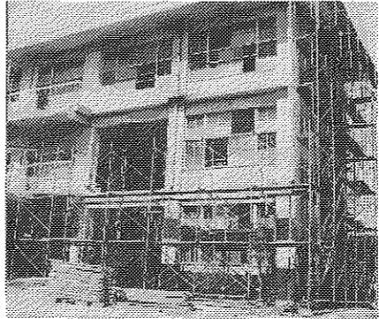
校舎の改修工事が始まった八幡小北校舎①と八幡第二小中校舎②
