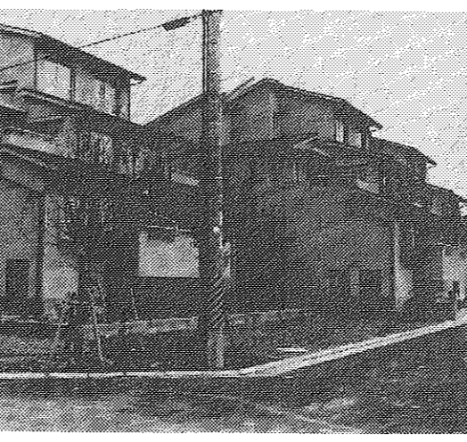
同和地区の住環境の改善につとめています(写真は改良住宅)
