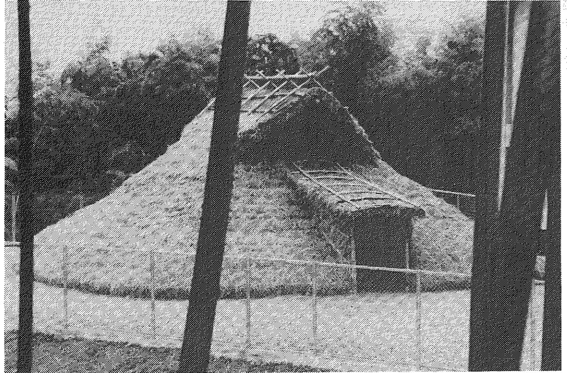
完成した堅穴式住居の全景
