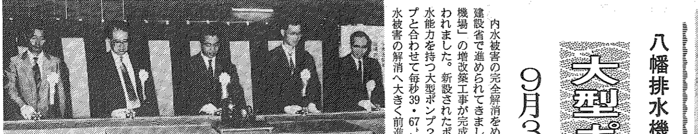
起動ボタンを押す(右から)西村市長、青山建設省専門官、荒巻京都府知事、萩原近畿地方建設局長、宮井淀川工事事務所長 (新ポンプ場内)
