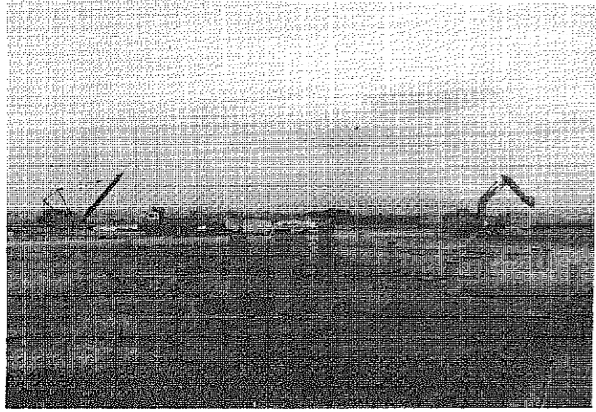
来年4月開校をめざし、急ピッチの(仮称)東部中建設工事
