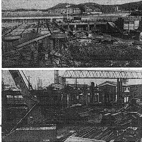
八幡第九保育園の建設現場
