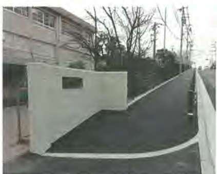
さくら小学校北側の拡幅後の歩道
