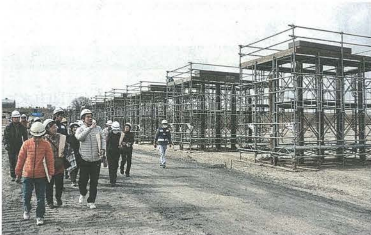
流れ橋の復旧工事を見学する参加者たち
