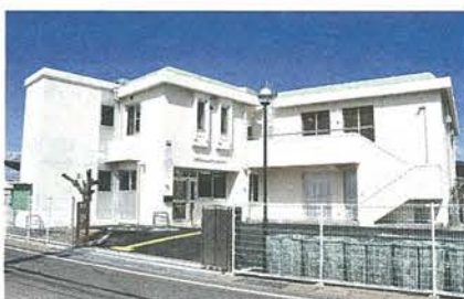
改修後の川口コミュニティセンター
