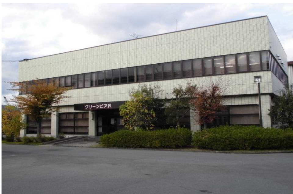
し尿及び浄化槽汚泥処理施設
