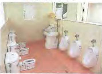
2 改修後のトイレ
