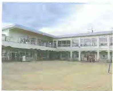
1 改修後の園舎
