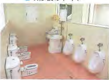
2 改修後のトイレ
