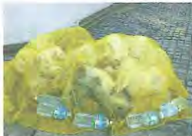
水を入れたペットボトルを重石として使用した例
