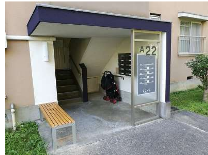
エントランス改修実施後
