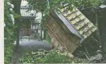
右：損壊した屋根瓦(市民より提供) 上：倒壊した数寄屋門 左：壁が崩れた家屋
