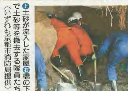
土砂が流入した家屋の橋の下で土砂等を撤去する隊員たち(いずれも京都市消防局提供)
