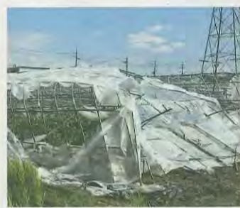
倒壊したビニールハウス
