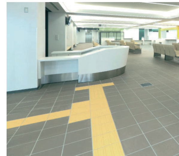
誘導ブロックの例
