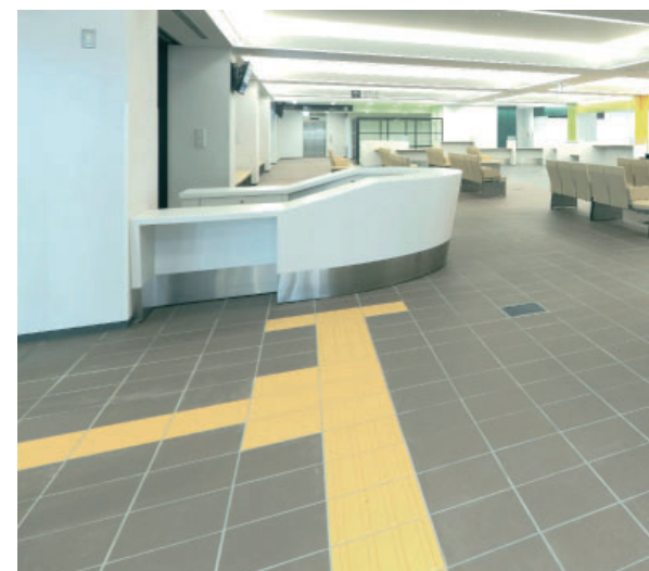
誘導ブロックの例
