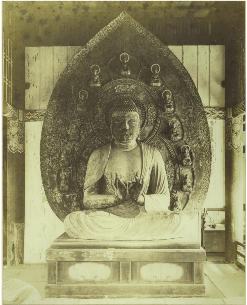
昭和 8 年(1933)に本尊を修理した際の堂内の様子(文化庁保管写真)
