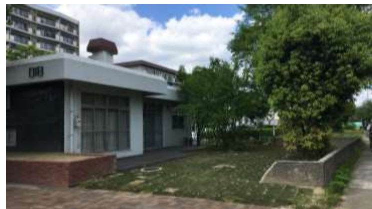
▲ 屋外空間整備後のD地区集会所
