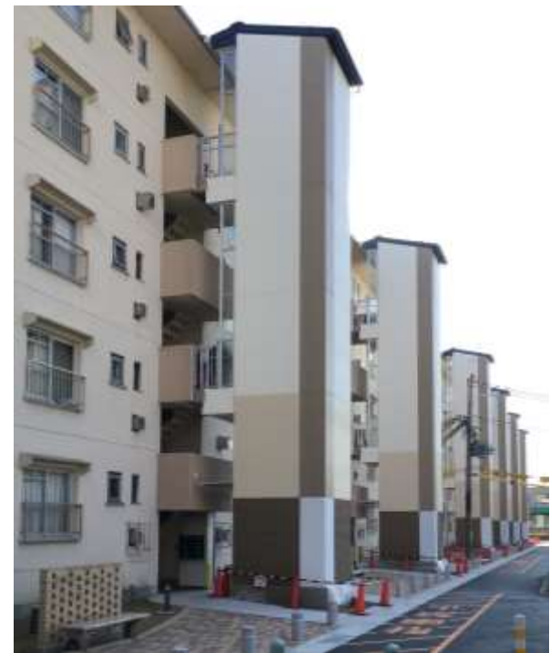
エレベーター設置工事の様子
