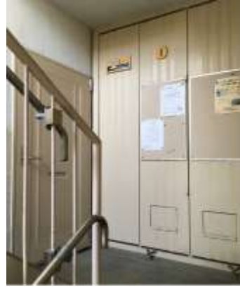
▲ 塗装前の玄関扉
