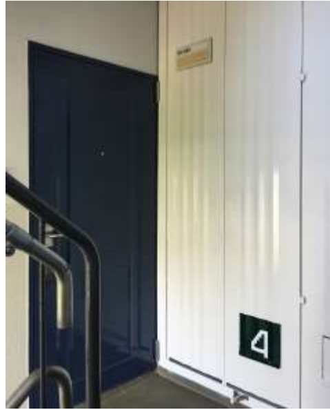
▲ 塗装後の玄関扉
