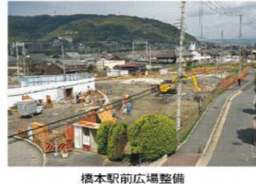
橋本駅前広場整備
