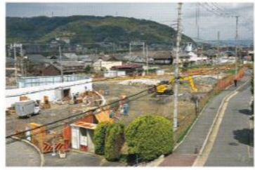
橋本駅前広場整備
