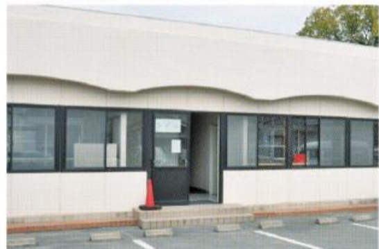
中区集会所が入る施設
