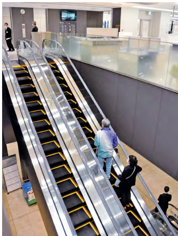
1階から2階まではエスカレーターで移動が可能
