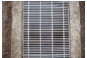
【細目のグレーチング】 車いすの前輪やつえ、ヒールのかかたが落ち込まなくなります。
