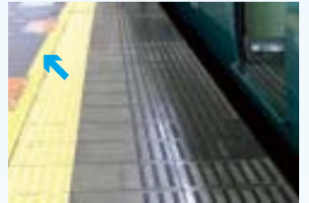
【内方線】 視覚障がいのある人が、ホームの端を知らせる点状ブロックの上に立ったときに、ホームの内側を知ることができます。
