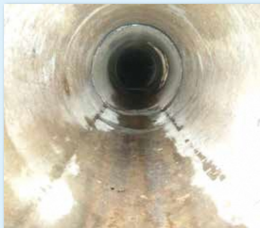
施工前 （更生前の管の内面）
