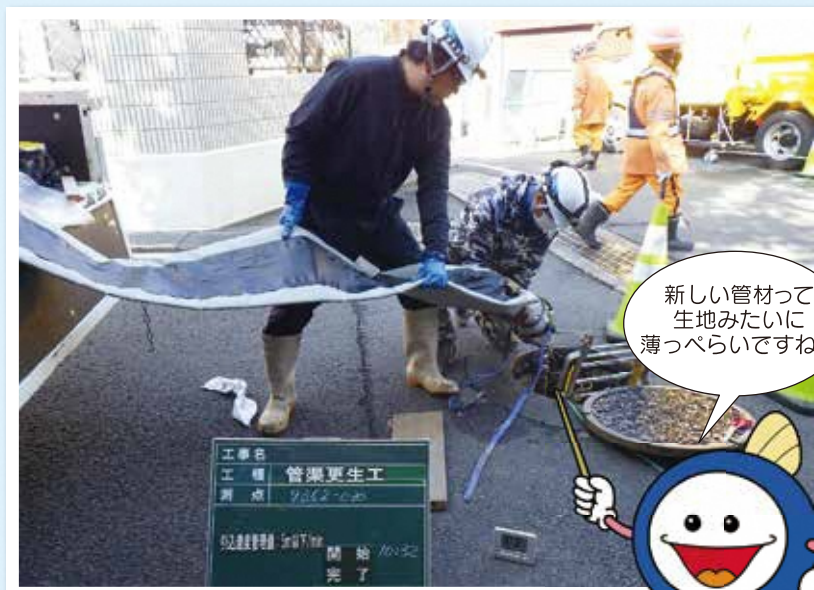
新しい管材を既設管路内に引込む作業
