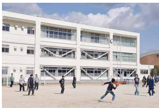
耐震化の完了した学校施設(橋本小学校)
