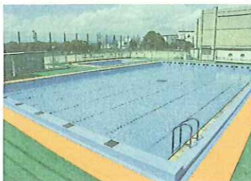
きれいに改修されたプール(有都小)
