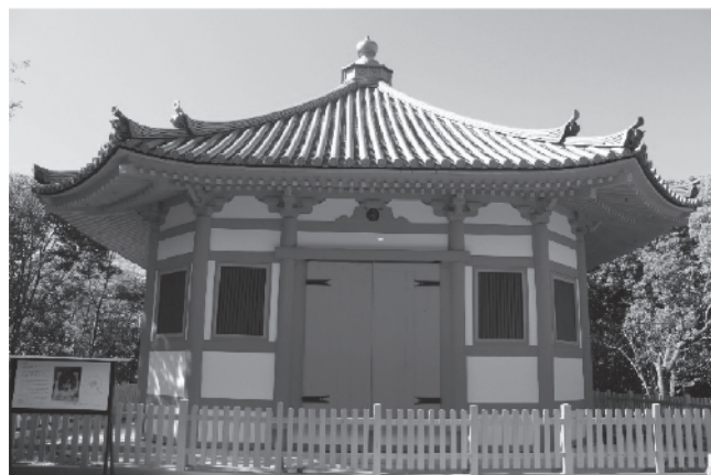
保存修理工事が完了した八角堂
