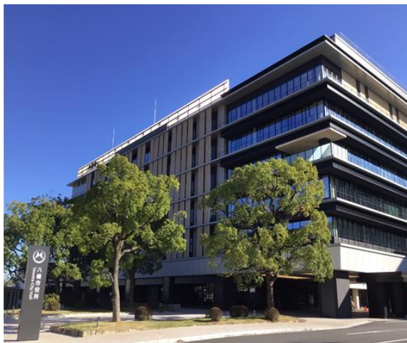
八幡市役所 新庁舎
