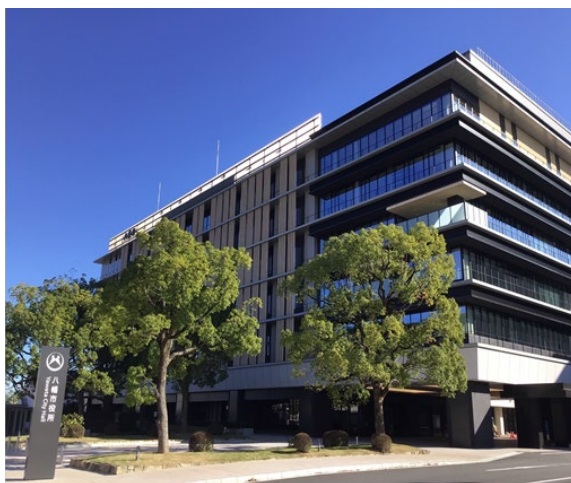
八幡市役所 新庁舎
