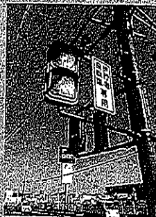
吉原交差点に設置された音響式信号機
