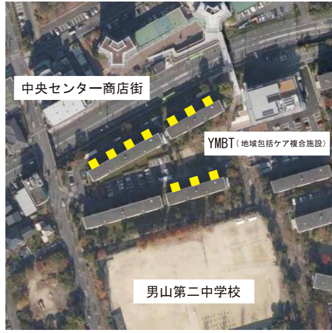
YMBTの並びに位置するB42、B44、B45棟の階段室に計10基のエレベーターが設置される予定。（H31工事完了予定）
