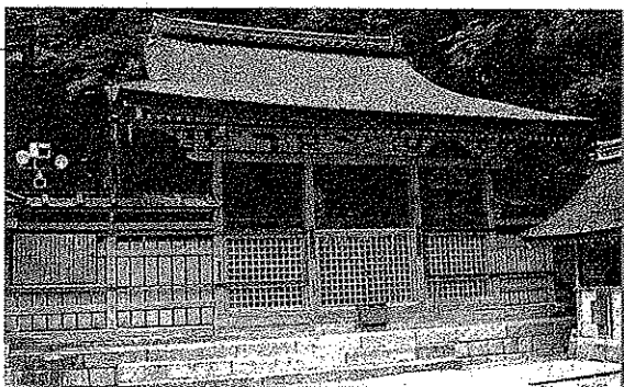
◆桁行三間、梁間二間、入母屋造、檜皮葺 ◇江戸時代前期
