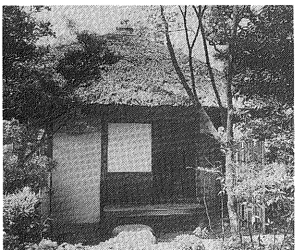
《史跡松花堂の茶室修繕》 茶室の柱や壁の老朽化、虫害による腐朽の進行防止、床の板の補修など、大規模な修繕。
